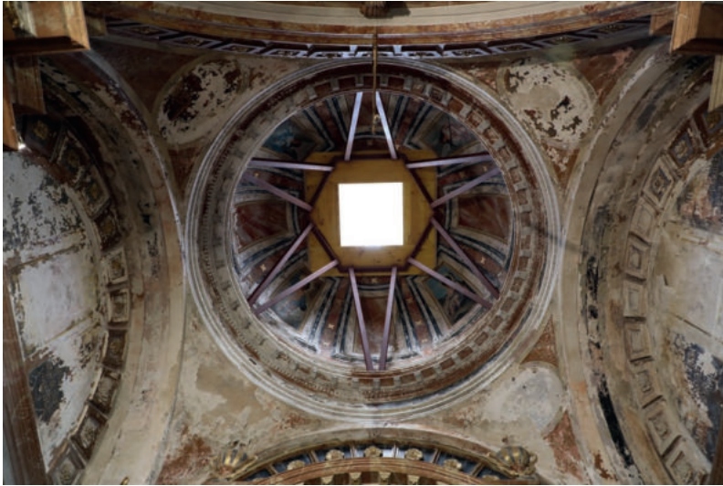
7. Estado actual de la cúpula arriostrada con estructura de hierro. Se pueden observar las pinturas de Luis del Águila (1904).
