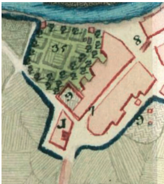
1. Detalle de la capilla del Rosario (J) al final de la calle de Castilla (7) junto a la Alcantarilla de las Madejas (8), en la salida a la vega de Triana. 1827.
