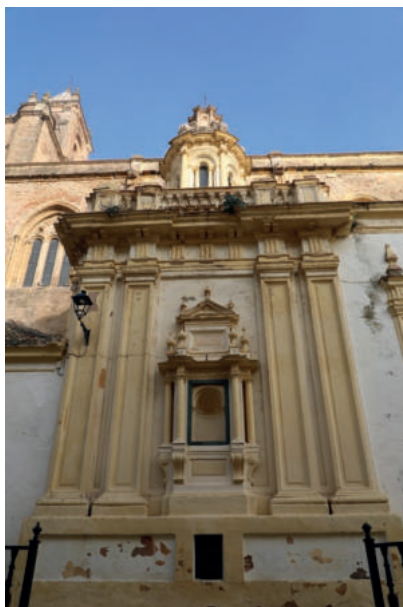
2. Exterior de la capilla. Lucas Cintora (1798-1801).
