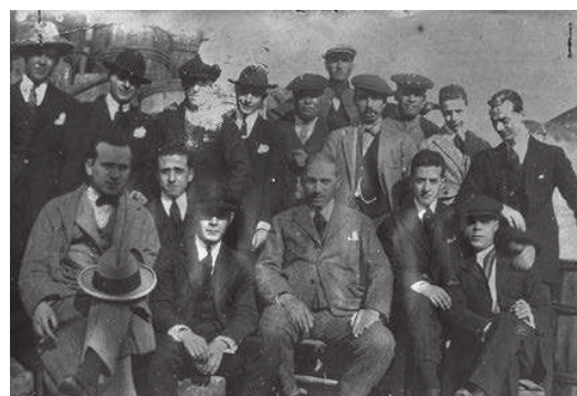
Rodeado de operarios de la fábrica (Archivo de la Fábrica Montalván)
